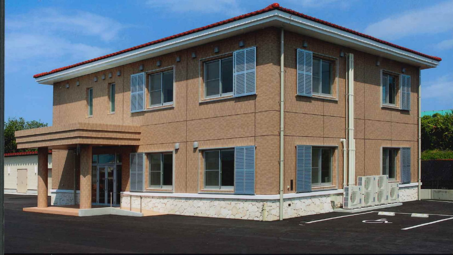
管理棟・車庫棟（西面）
